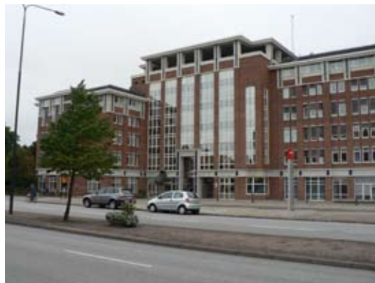
E.ONs kontorsbyggnad i Verket 3
