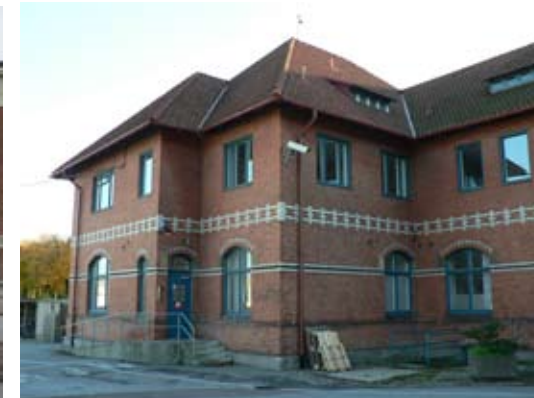
Äldre byggnad i Verket 4
