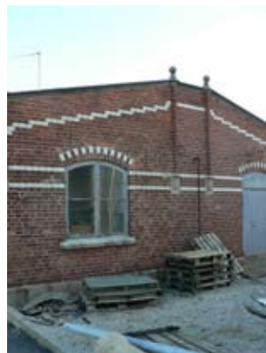
Äldre byggnad i Verket 4
